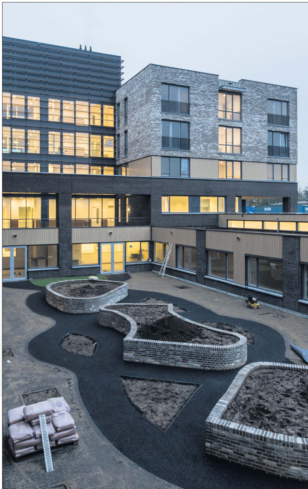
Het nieuwe zorgcentrum Op den Toren, met de tuin van de gesloten afdeling voor dementerenden (boven).
